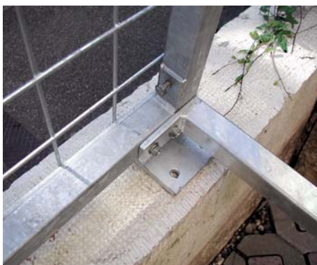
Fixierung mit den Rahmenschrauben
