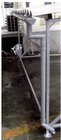
Dachkänel mit den Spezialhaltern an den Eternitplatten fixieren.
