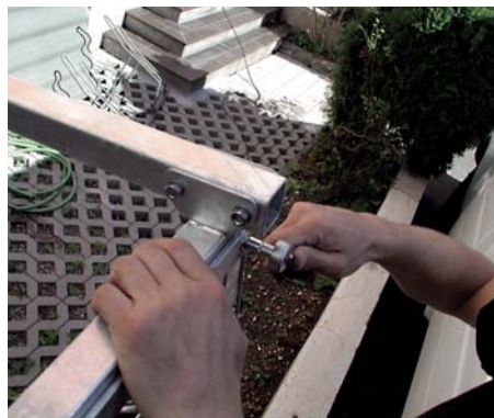
Montage oben \varnothing 5 mm Loch bohren und mit Schraube fixieren
