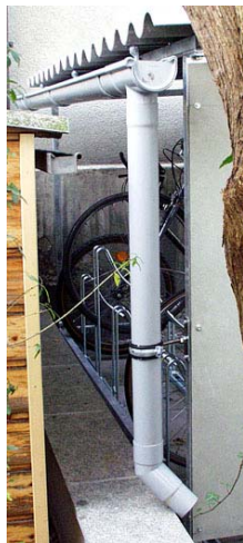
Montage des Abfallrohres am Rahmen mit den Schellen.
