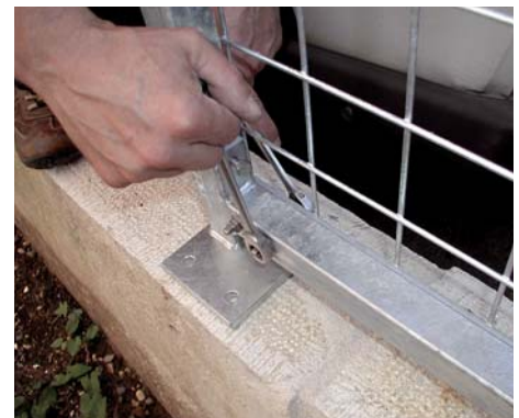
Montage unten an vorgebohrte Löcher
