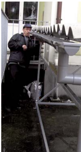
Kontrolle ob Dachkänel gerade montiert ist und das Wasser abfließt.
